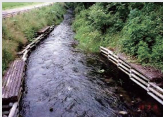
写真2-3-6 環境との調和に配慮した排水路
