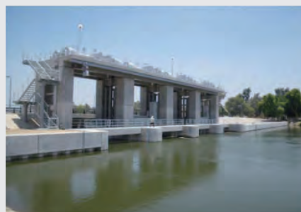
写真 特 30 ダハブ せき 堰（改修後）
