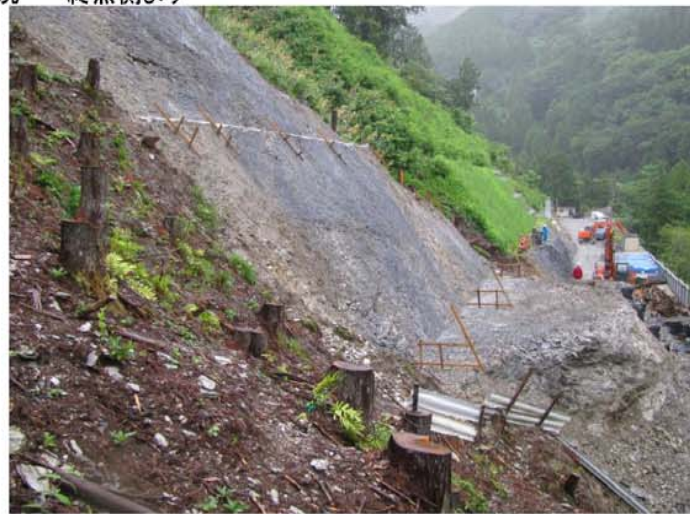
1段目のり面状況 終点側より
