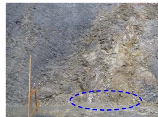
湧水状況 ② 強風化脆弱部からの湧水拡大写真
