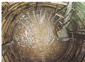
集水井の中に入った地下水
