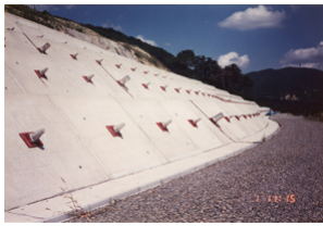
アンカーの工事後
