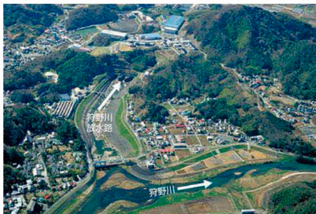
写真8 狩野川放水路
